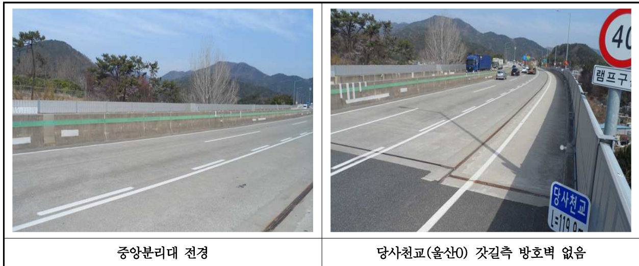
【사진 12.3.24】 방호벽 및 중분대 전경
