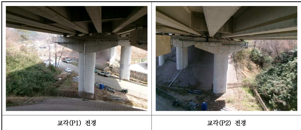
【사진 12.3.10】 교각 전경
