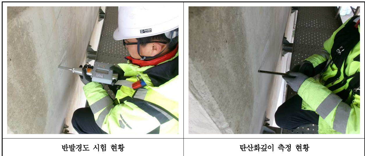
【사진 12.4.1】 콘크리트 내구성조사 현황
