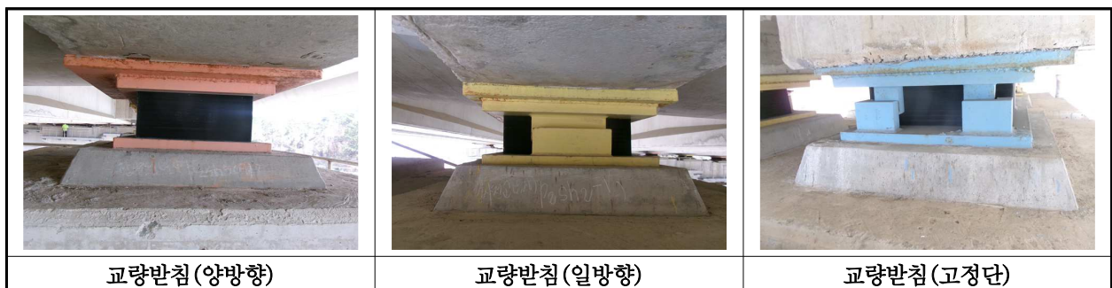
【사진 12.3.13】 교량반침 전경
