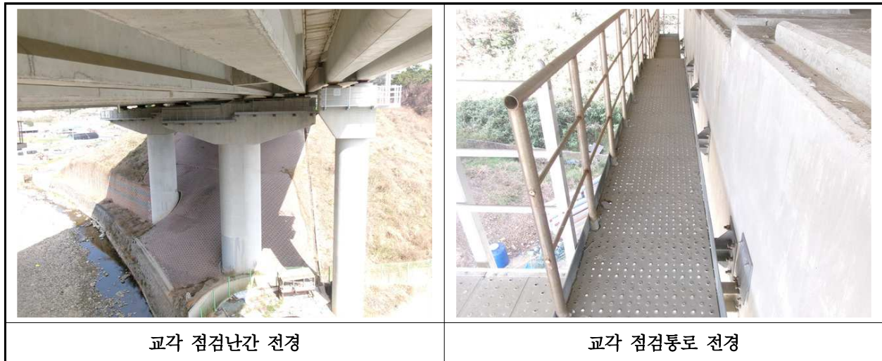
【사진 12.3.26】 교량 점검시설 전경
