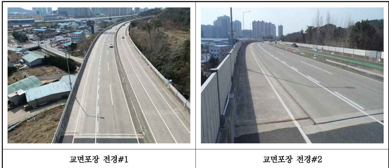
【사진 12.3.20】 교면포장 전경
