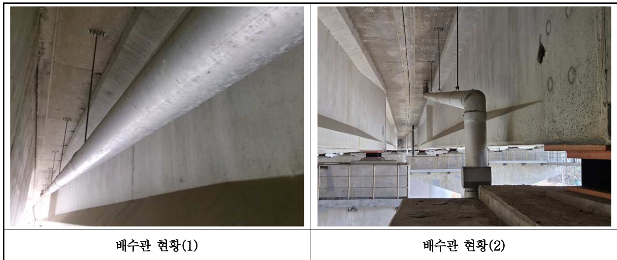
【사진 12.3.22】 배수시설 전경
