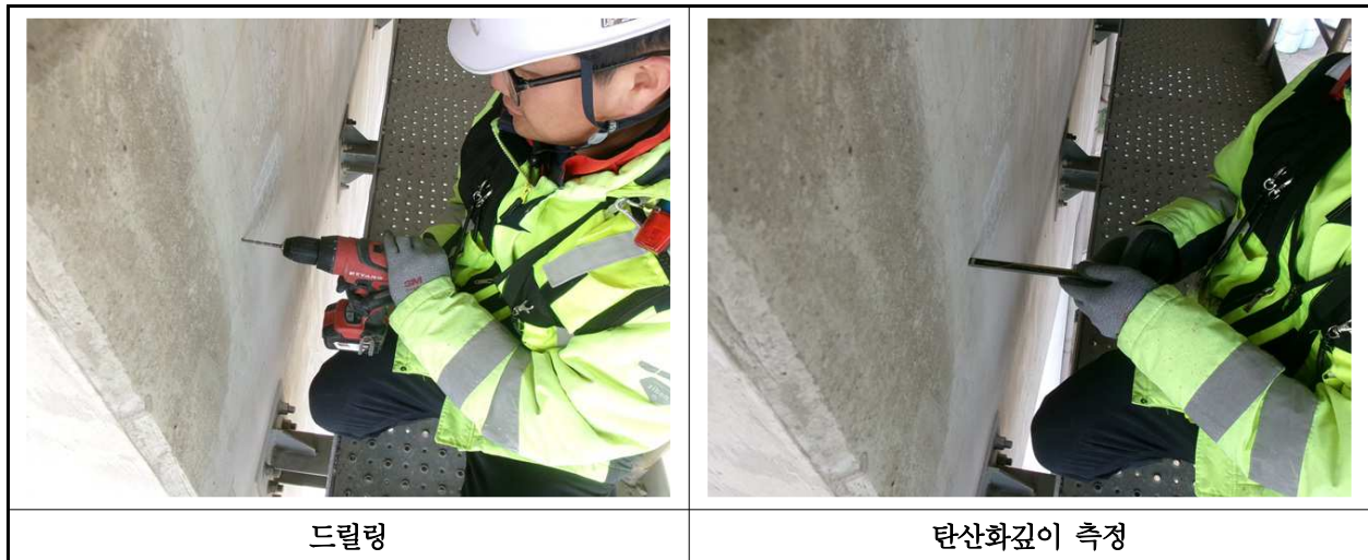
【사진 12.4.3】 탄산화 깊이 측정 현장사진
