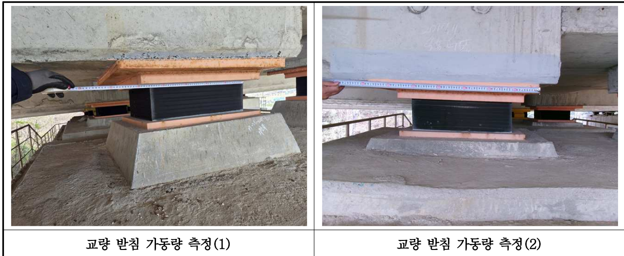
【사진 12.3.16】 교량받침 이동량 측정
