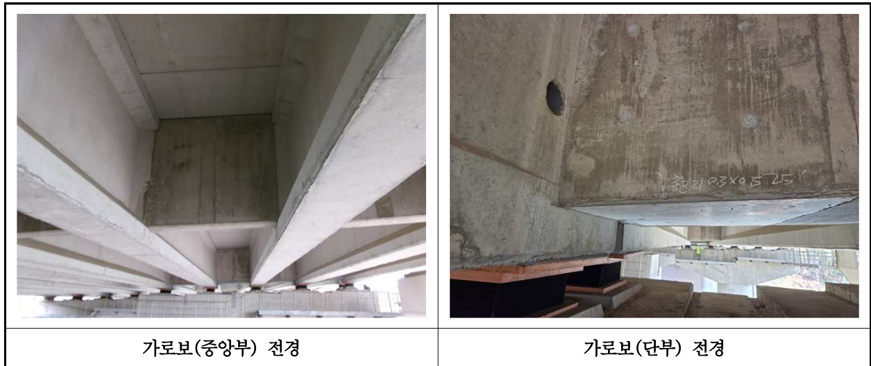
【사진 12.3.6】 가로보 전경
