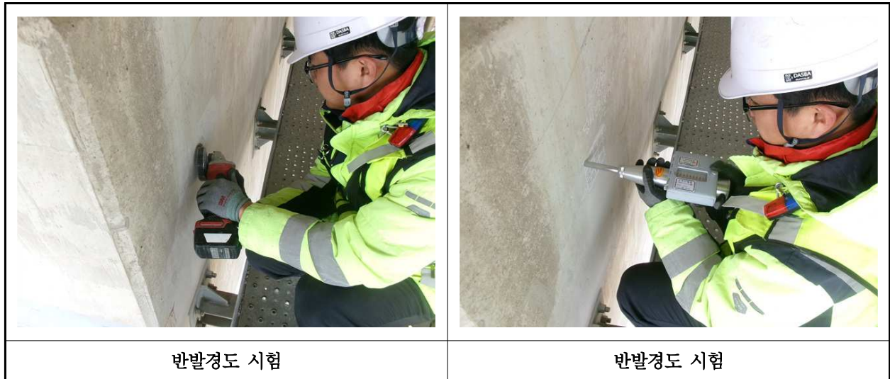
【사진 12.4.2】 반발경도시험 현장사진
