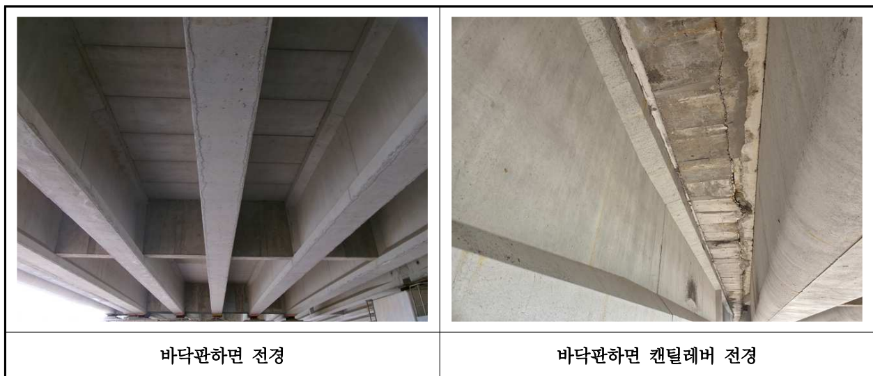
【사진 12.3.2】 바닥판하면 전경
