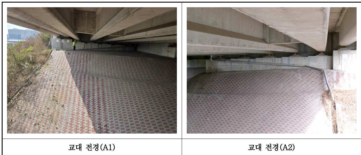
【사진 12.3.8】 교대 전경
